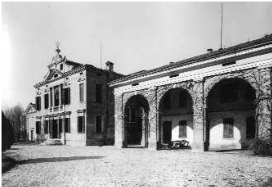
Stato attuale. Veduta della barchessa (Archivio IRVV)
