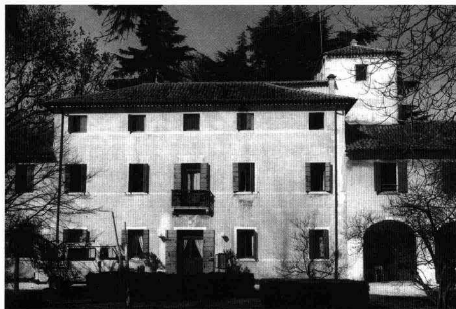
La facciata principale della villa e, sul retro, il volume della colombaia (Archivio IRVV)
