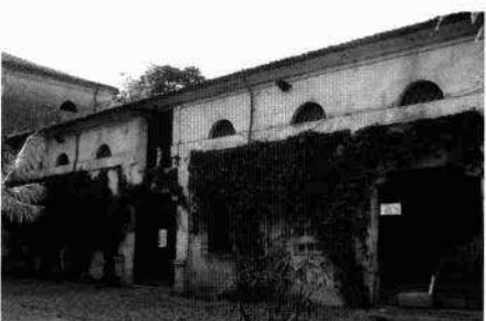
La quadrifora del corpo a torre L'interno del portico Veduta esterna del portico meridionale Gli annessi orientali
