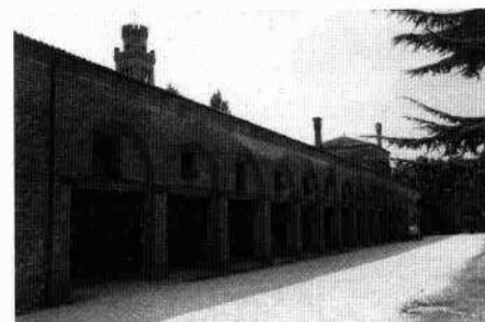
Veduta di un ambiente interno della villa (Archivio IRVV) La facciata dell'oratorio (L.S. 1998) Scorcio del lungo corpo delle adiacenze porticate (L.S. 1998)
