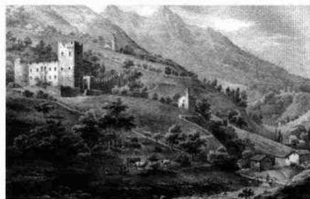
L'edificio e l'oratorio nella litografia di Marco Moro (da: Vecellio, 1876) Particolare del fronte sud e del bastione circolare (L. De Bortoli, 2003)
