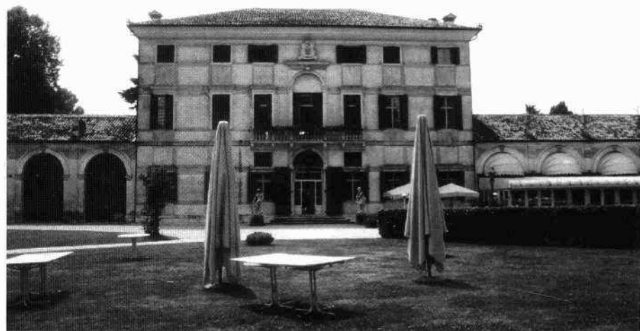
L'ala porticata sul fronte nord (Archivio IRVV) La facciata nord della villa (L.S. 1998)
