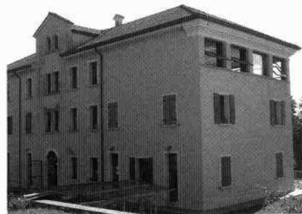
Particolare del fronte principale (L. De Bortoli, 2003)
